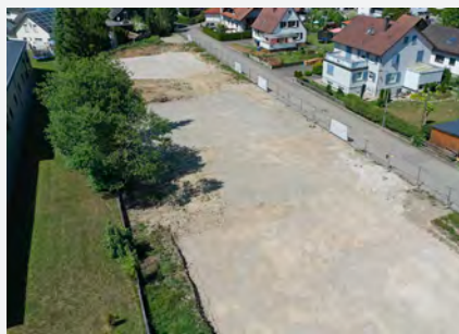
Mehrfamilienhäuser Sigmaringendorf, Braunhaldenstraße
