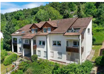
Mehrfamilienhaus Bad Wildbad-Calmbach, Enzring 46
