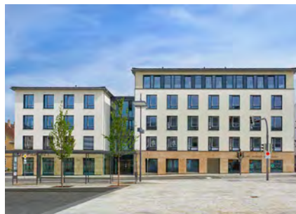
Geschäftsgebäude Sigmaringen, Leopoldplatz 1
